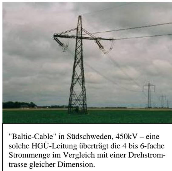
"Baltic-Cable" in Südschweden, 450kV – eine solche HGÜ-Leitung überträgt die 4 bis 6-fache Strommenge im Vergleich mit einer Drehstromtrasse gleicher Dimension.
